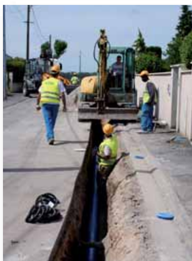
Le hameau des Houis ; travaux avant...
